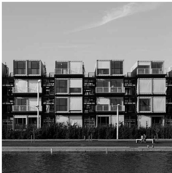
Vue de la façade sud du bâtiment.
